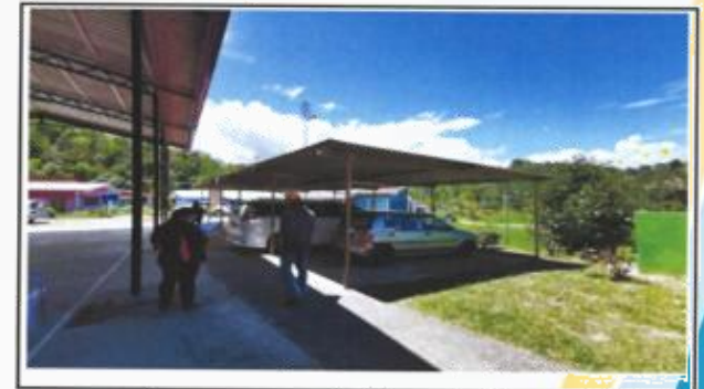
Garaj perlu dirobohkan bagi laluan jentera berat ke Kawasan tapak bina
