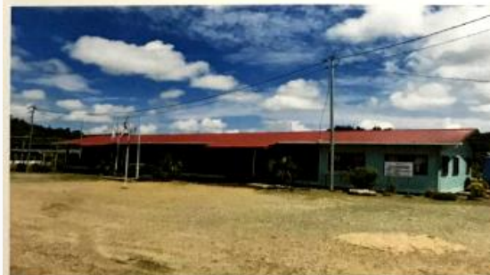
BANGUNAN BILIK DARJAH - BLOK B
