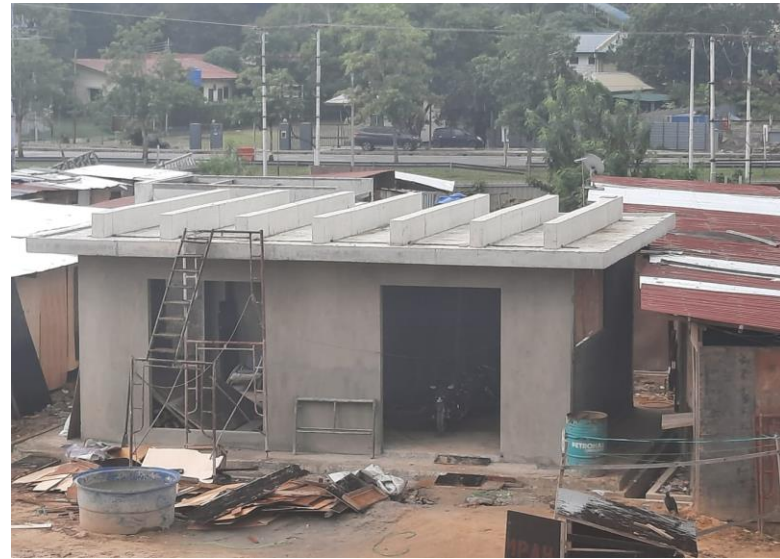
Bangunan Genset & Rumah Pam
