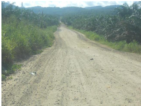
Jalan batu kelikir di sepanjang jalan
