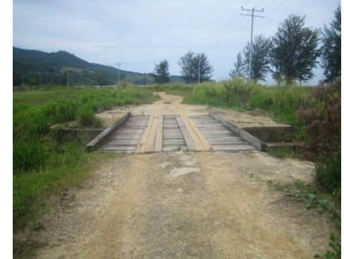
KM 15.50 Jambatan Teringai Laut
