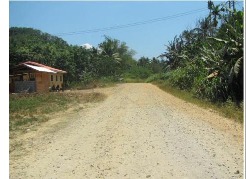
Jalan batu kelikir di sepanjang jalan
